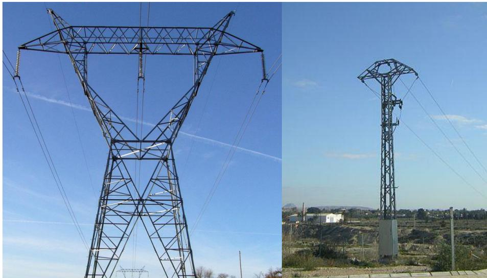
Fig.-3.2 Torres y cables de Alta (Izda.) y Media (Dcha.) Tensión
