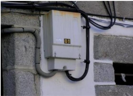
Fig.-3.5 CGP instalado sobre fachada.
