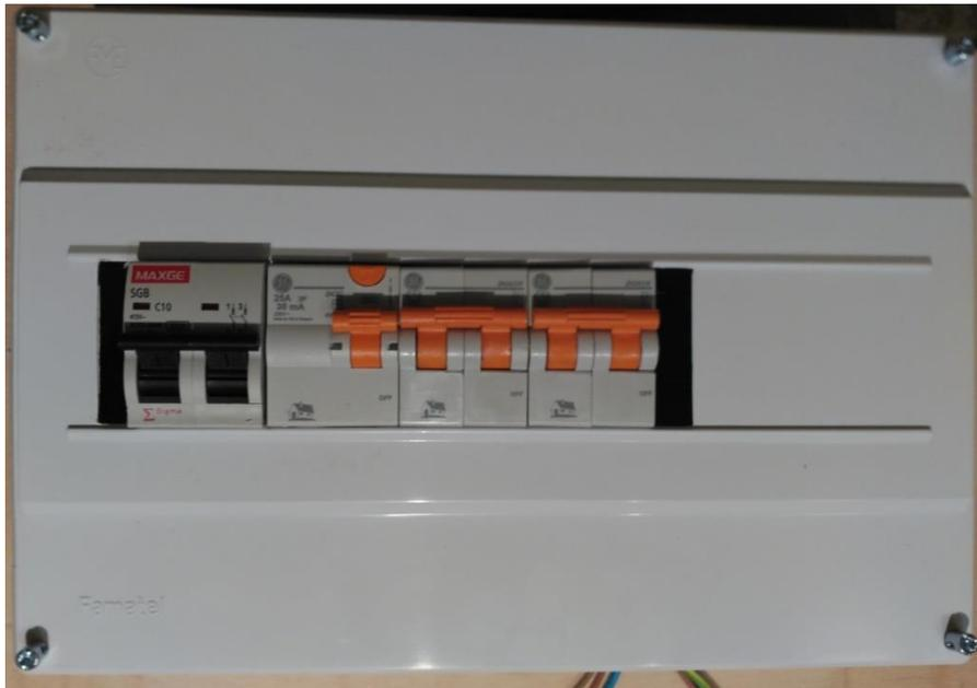
Fig.-3.22 Instalación de la CGMP terminada. (Fuente: propia)
