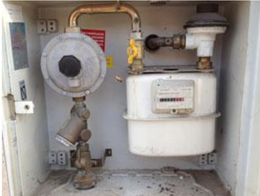
Fig.-4.11 regulador de gas, válvula de usuario y contador. (Fuente: propia)
