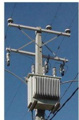
Fig.-3.3 Transformadores de Alta a Media (Izda.) y de Media a Baja Tensión (Centro y Dcha)
