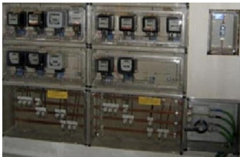
Fig.-3.8 Esquema y cuadro centralizado de contadores
