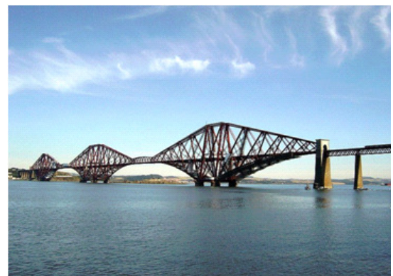
Puente ménsula , Puente ferroviario, Forth.
