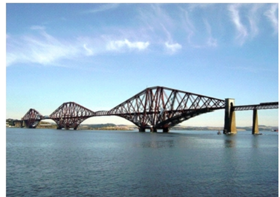
Puente ménsula, Puente ferroviario, Forth.
