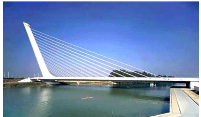
Suspension Bridge, El Alamillo, Sevilla.
